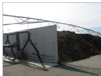
▲ Process – plate-forme corquilleroy
